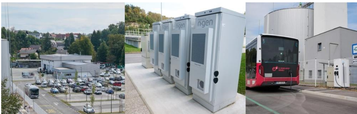
Fotografije uspešno zaključene Prve faze gradnje Parka krožnega gospodarstva
