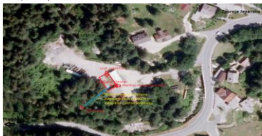
Oris: Foto posnetek stavbe MNOV, ZJ223510
